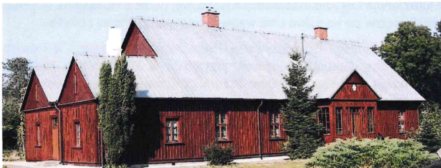
Budynek ŚDS w Miedźnie
